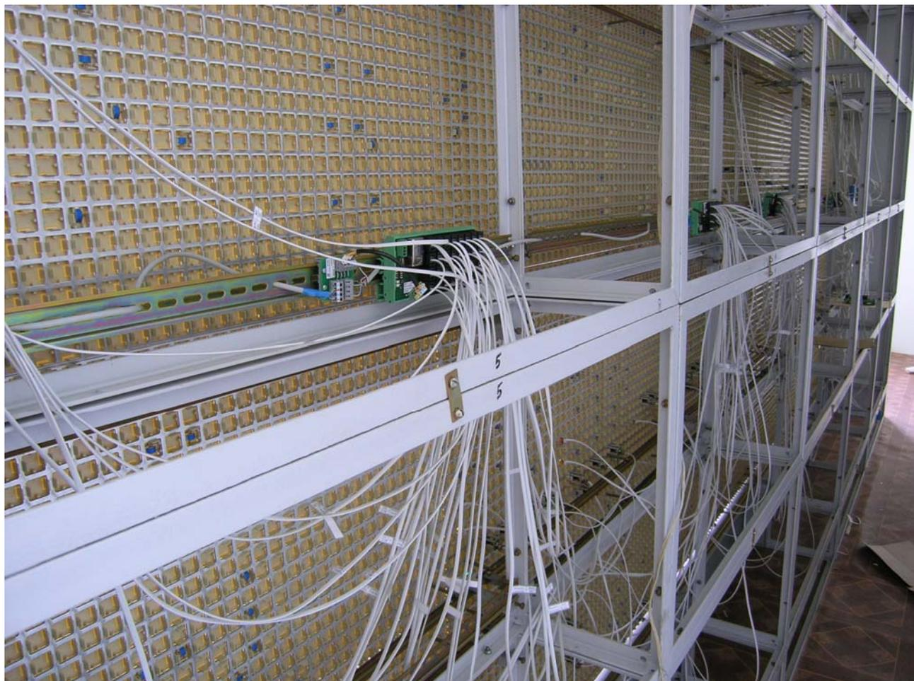
Рисунок 11 – Процесс монтажа системы управления на щите
