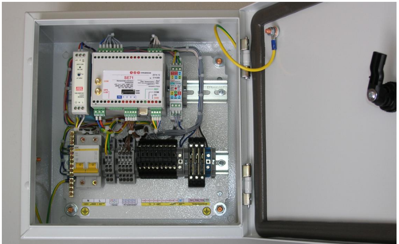
Рисунок 3 – Фото УКП с открытой дверцей шкафа
